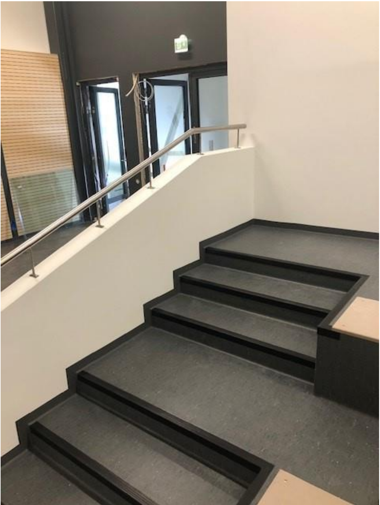
Katsomo pääosin valmis. Viimeistelytyöt kesken.
