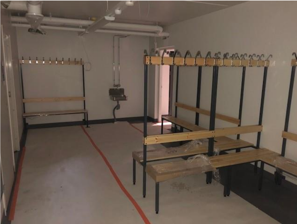
Pukuhuoneet kalustettu ja varusteltu. Maalauskorjaukset käynnissä.
