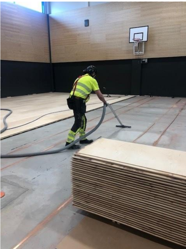
Urheilulattian asennus käynnissä. Lattiaan asennettu induktiosilmukat.
