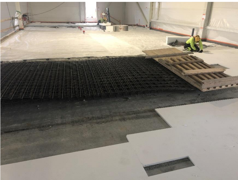
Parven toinen puoli valetaan tällä viikolla. Käynnissä on valuvalmistelut!
