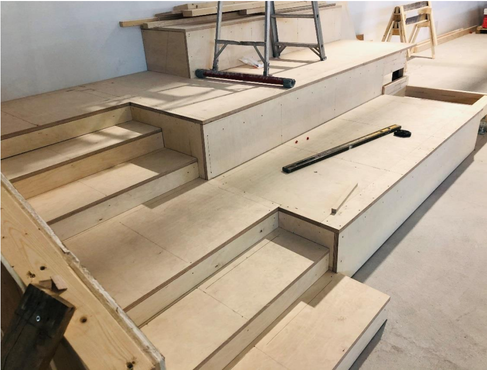
Katsomon runko valmistumassa. Vanerin päälle asennetaan tumma matto.
