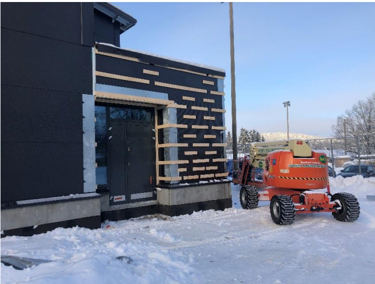
Ulkoverhouksen asennus alkamassa
