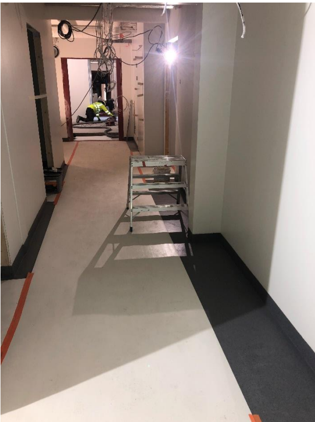
Vss tilojen lattiapinnoitukset valmistumassa.
