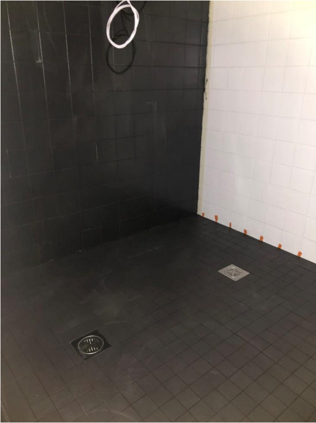
Suihkuhuoneen laatoitukset tehty.
