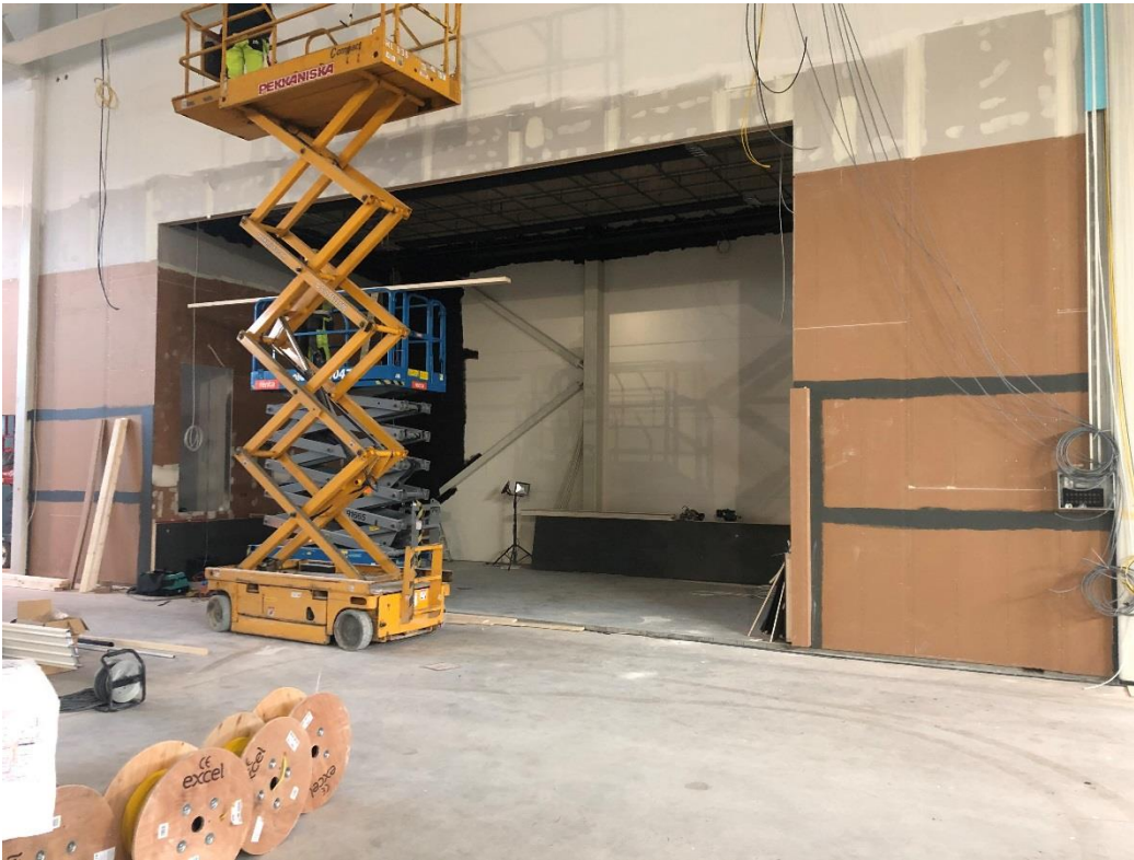
Näyttämön alakattorirunko asennettu. Tekniikka-asennusten jälkeen tehdään korotettu lattia.
