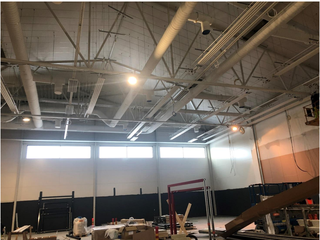
Salin akustovillaa asennettu ja talotekniikka-asennukset käynnissä
