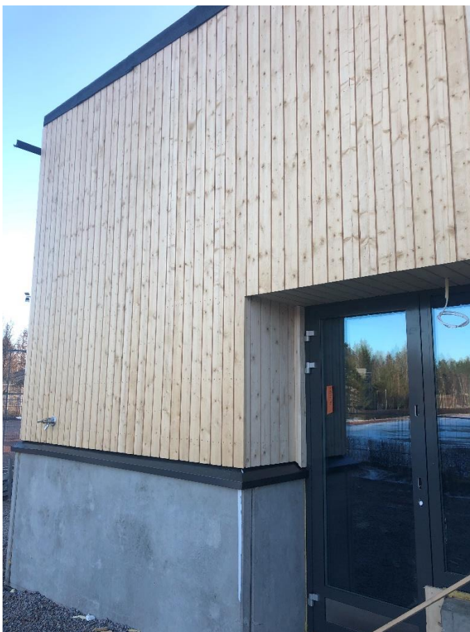
Varaston seinät paneloitu. Viimeistelytyöt aloitettu (listoitukset, pellitykset yms.)
