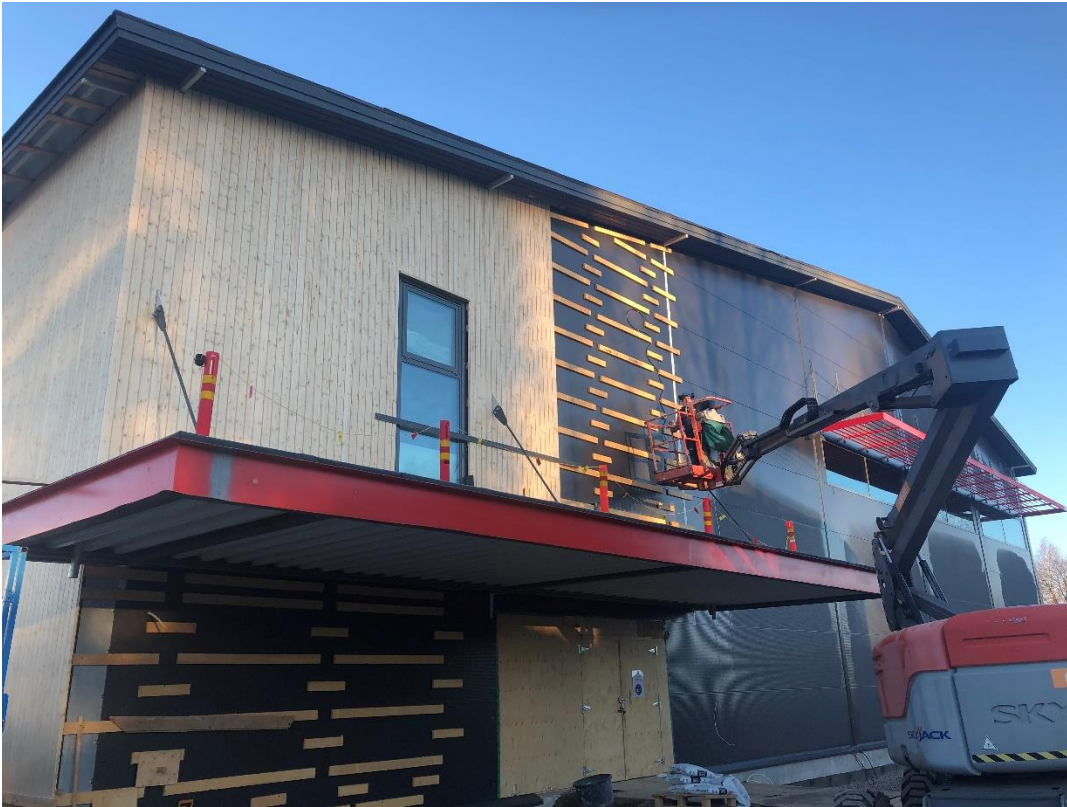
Julkisivun panelointi viimeisellä sivulla. Taustalla näkyy myös asennettuna aurinkosuojasäleiköt.
