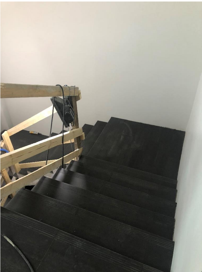
Seuraavaksi suojataan portaat ja asennetaan kaiteet ja käsijohteet
