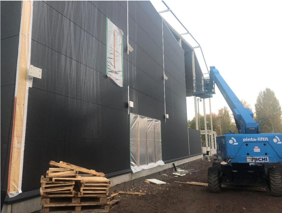
Julkisivun asentamista Virkatien puoleisessa päädystä.
