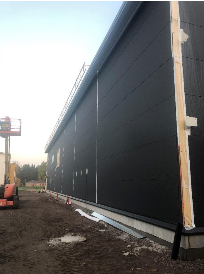
Koulunpuoleisen sivun elementit pääosin asennettu.
